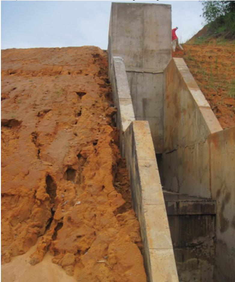
Photo 10. Dégâts sur les talus et les remblais contigus du collecteur du site Casis (Déc. 2009)
