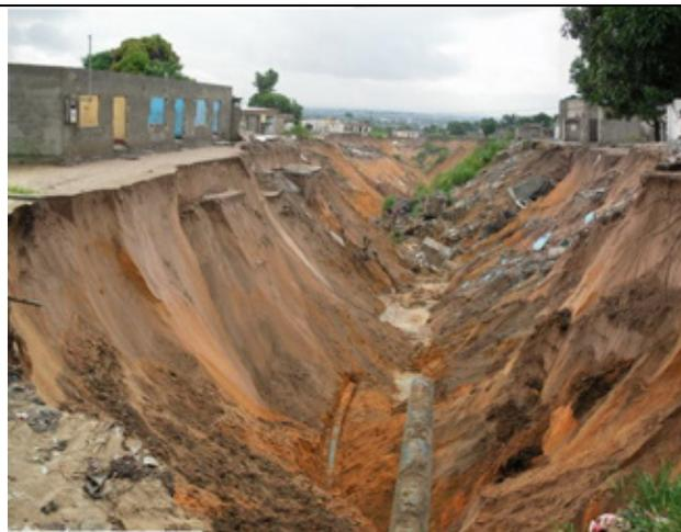
Photo 1. Etat initial du ravin boukeni, avant mise en place des sacs des sables et plantation de vétiver
