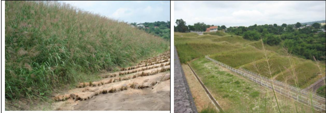
Photos 13 et 14. Mêmes talus des photos 11 et 12 (en mai 2011), ayant bien résisté contre les érosions en dépit des pluies exceptionnelles supérieures à 70mm
