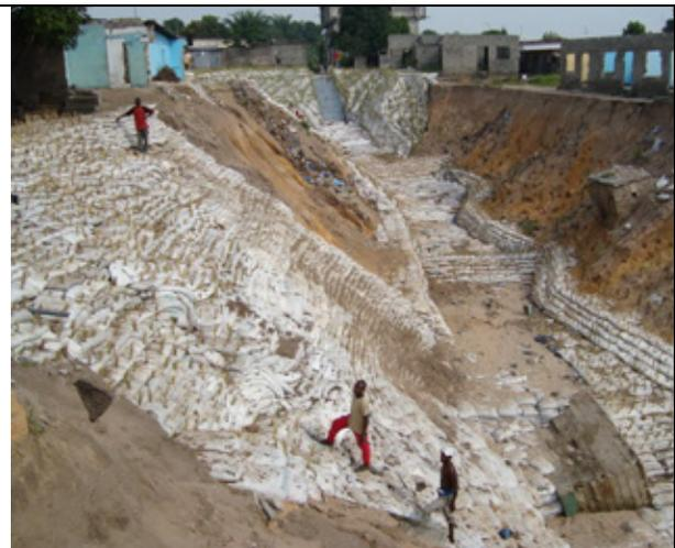
Photo 2. Mise en place des sacs de terre végétale et plantation de vétiver sur le site Boukeni (février 2009)
